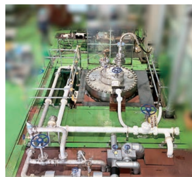
LNG Pump Operational Test
