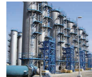
送水ポンプ場での圧力タンク (UAE)
