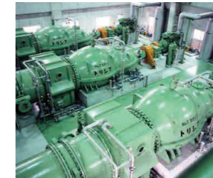
農業排水ポンプ場 (佐賀県)
