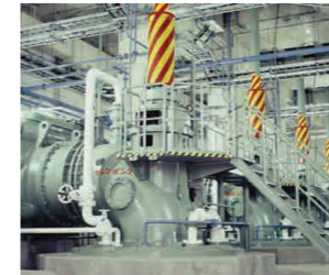
雨水排水ポンプ場 (東京都)
