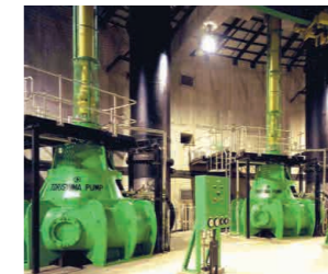
下水送水用 中継ポンプ場 (香港)
