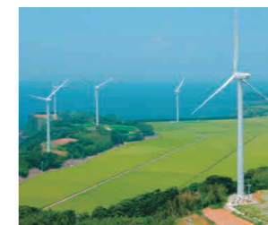
1500KW風車 (佐賀県玄海町)
