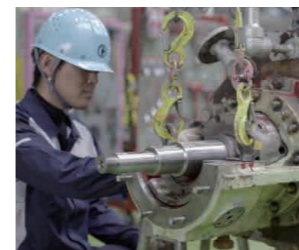
ポンプのオーバーホール
