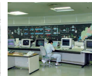
ポンプ設備の運転管理
