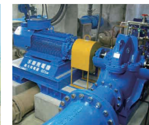
小水力発電システム
