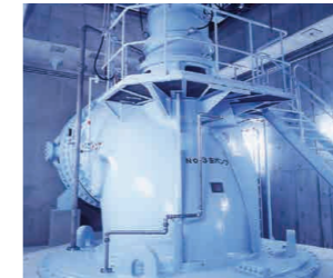
河川排水ポンプ場 (大分県)
