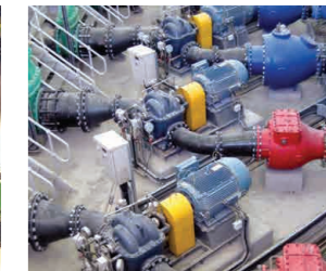
上水道用 配水ポンプ場 (カタール)
