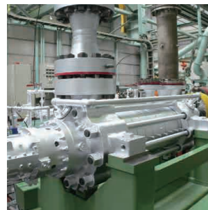
発電プラント用 ボイラ給水ポンプ
