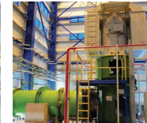
発電プラントでの冷却水ポンプ設備 (ベトナム)
