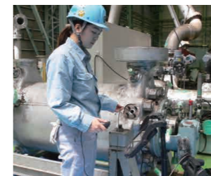
内視鏡カメラによる ポンプの内部診断
