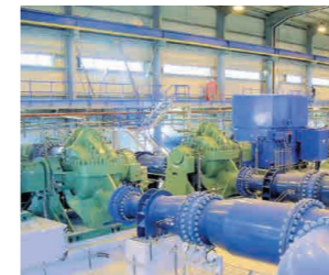
上水道用 長距離送水ポンプ場 (UAE)
