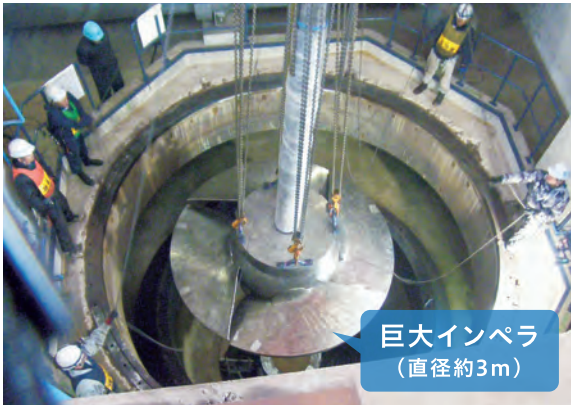
大形排水ポンプの据付
