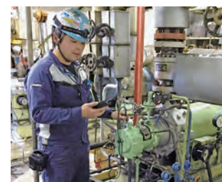
ポンプの診断作業
