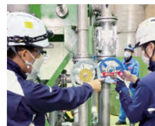
現場での施工管理作業
