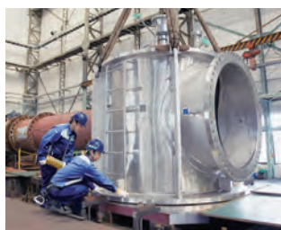
試験ピットへの大形ポンプ据付作業
