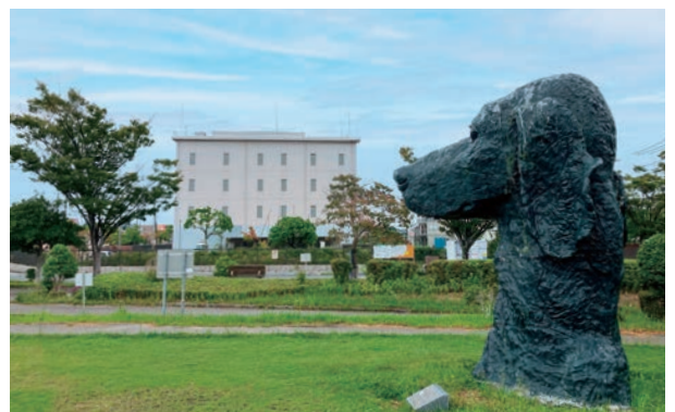
小串ポンプ場外観
