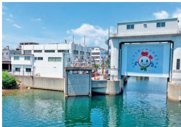
大輪田ポンプ場外観
