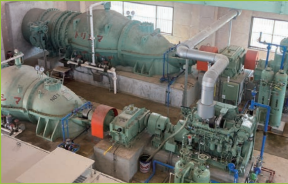
下仁井田排水機場
