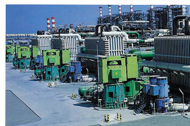
海水淡水化プラント用各種ポンプ アルタバールMSF海水淡水化プラント (アラブ首長国連邦) 向
