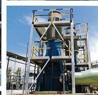
海水冷却ポンプ (シンガポール) 向 □ 径：800mm 原動機：790kW
