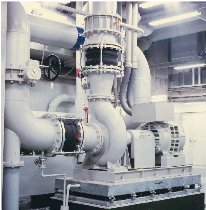
冷却水ポンプ／地域冷暖房設備
