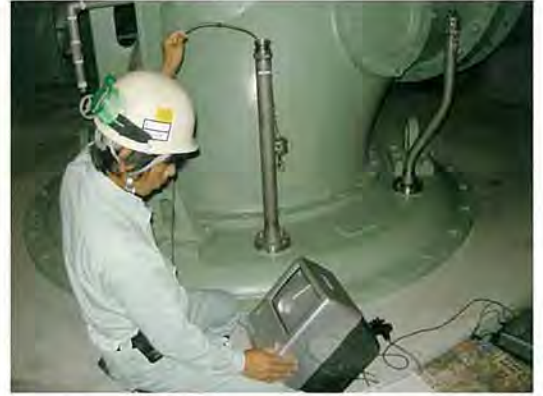
内視鏡による水中軸受の目視確認状況
