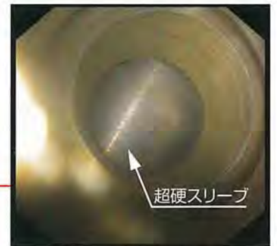
軸受ケーシング注入口
