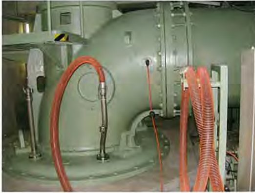
実機ポンプでの水中軸受隙間測定状況 (口径 1350mm 立軸斜流ポンプ)
