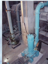
某下水処理場
