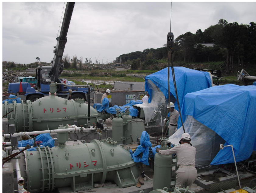
津波により全損、機能停止した排水機場の復旧作業（被災地にて当社撮影）
