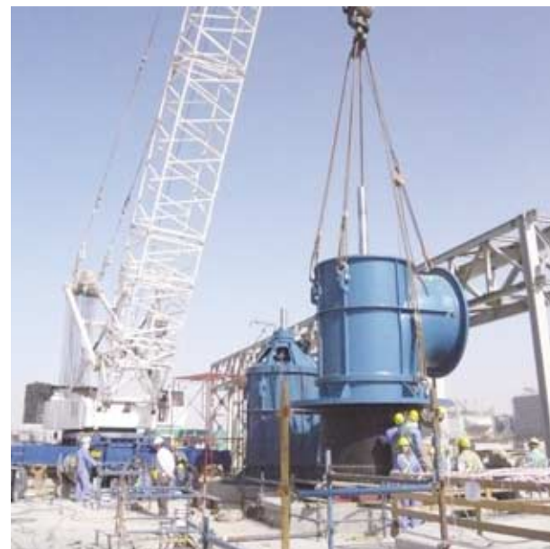
プラントへのポンプの据付
