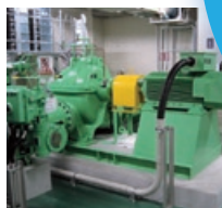
小水力発電システム (ポンプ逆転車)
