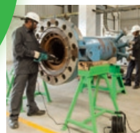
ポンプのオーバーホール
