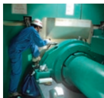
大型風車ナセル内の点検
