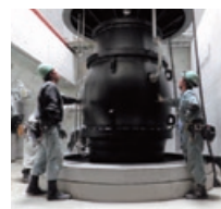
排水ポンプの据付
