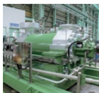
発電プラント用 ボイラ給水ポンプ
