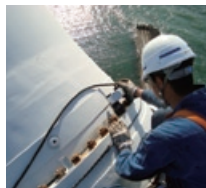
大型風車ブレードの点検
