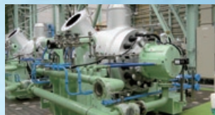
サウジアラビア Rabigh II 発電所(700MWx4)向け ボイラ給水ポンプ(原動機容量:13,500kW) 2012年納入
