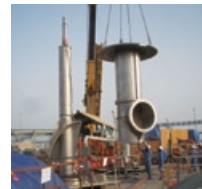
冷却水ポンプの据付
