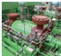
発電プラント用 ボイラ給水ポンプ
