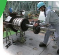
ポンプのオーバーホール
