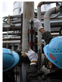
▲流量計取付の様子
