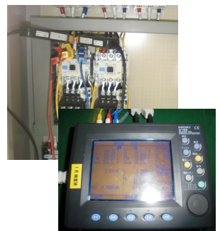
▲消費電力量の測定
