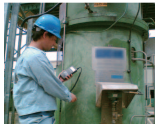
ポンプの騒音振動測定
