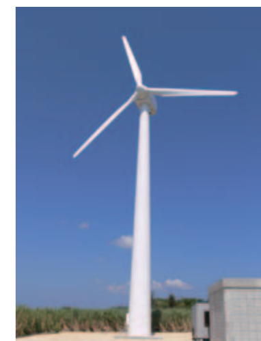
100kW風車(沖縄県久米島)
