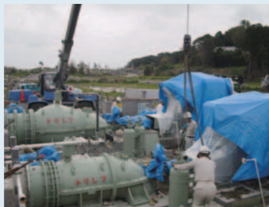
津波により全損、機能停止した排水機場の復旧作業
