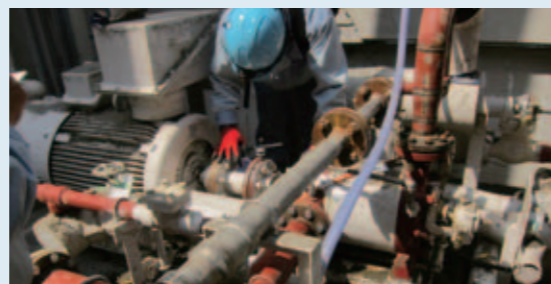
津波被害を受けた火力発電所での現地調査
