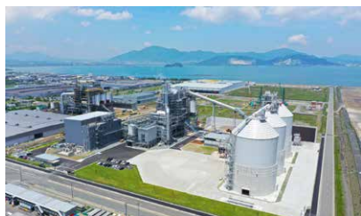
2021年6月に運転を開始した福岡県 荊田バイオマス発電所(約75MW)
