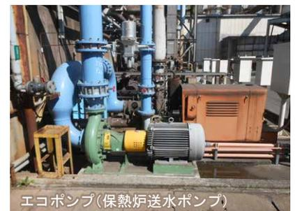
保熱炉送水ポンプは、保熱炉が稼働している間は常に運転し、さらには炉が稼働する前日から炉が止まった次の日まで運転することもあり、圧延プロセスの中で最も稼働時間が長いポンプです。そのため省エネ効果に期待できるという点もエコポンプを導入する決め手となりました。松原さんが、トリシマの省エネ報告書を片手にポンプ導入ビフォーアフターで「消費電力を10%削減できるのは大きいよね」と省エネ効果に笑顔で太鼓判を押してくださいました。「実際に効果が目に見えて実感できているか」というと、ポンプ一台ではわからないのが正直なところだけれど、トリシマの営業がポンプ導入前と後に実際に来てくれて、ポンプを測って省エネ提案書・報告書の形で提示してくれるのでわかりやすい」と、トリシマの営業が熱心に何度も通ったことも評価していただきました。
