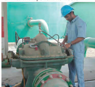
Капитальный ремонт на месте
