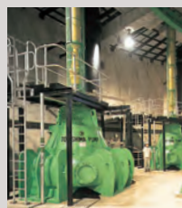
Вертикальный насос смешанным спиральным корпусом для сточных вод в Гонконге
