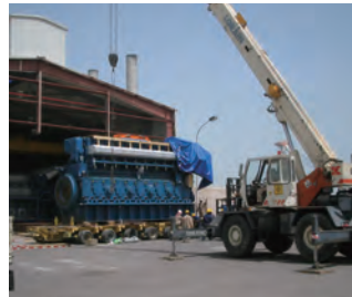
Установка генератора Кувейт
