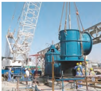
Установка насоса потребляющей морской воды
