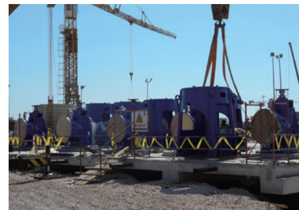
バハル・アル・バカル水処理プラントに据付中の処理水ポンプ
