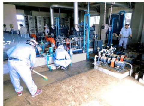
豪雨后、浸水した排水機場の復旧作業
