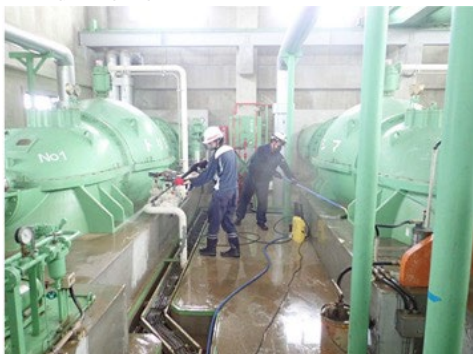
豪雨后、浸水した排水機場の復旧作業
