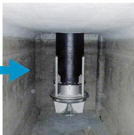
吸水槽内の吸込み管（渦対策機構付き）
