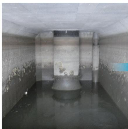
吸水槽内の吸込み管（渦対策なし）
