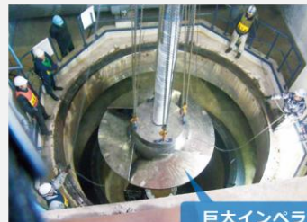
大形排水ポンプの据え付け
