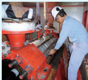
ポンプの現地整備
