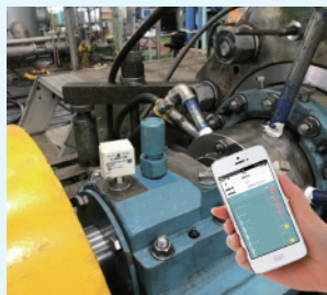
保守点検(機械状態の監視)
