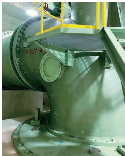
エンジン駆動の口径2,200mmポンプ
