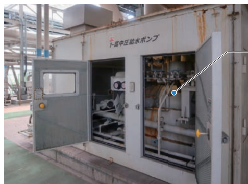
高中圧給水ポンプ (ボイラ給水ポンプ)
