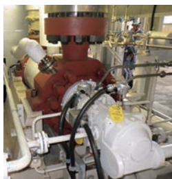
高中圧給水ポンプ (ボイラ給水ポンプ)
