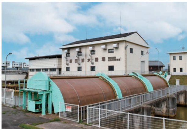
新田排水機場外観
