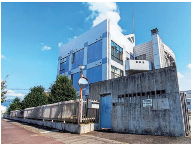
山梨県発電総合制御所
