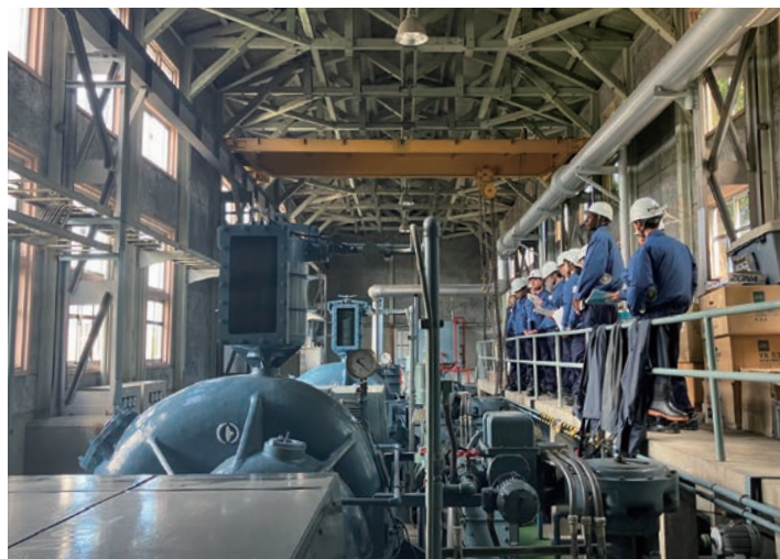
ポンプ場見学
