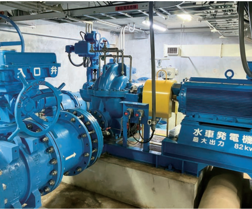
ベテラン技術者は、聴診器を使用し微妙な音の違いで軸受の潤滑状態を判断するため、長年の経験が必要
