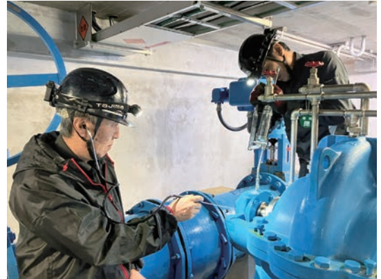
ベテラン技術者は、聴診器を使用し微妙な音の違いで軸受の潤滑状態を判断するため、長年の経験が必要
