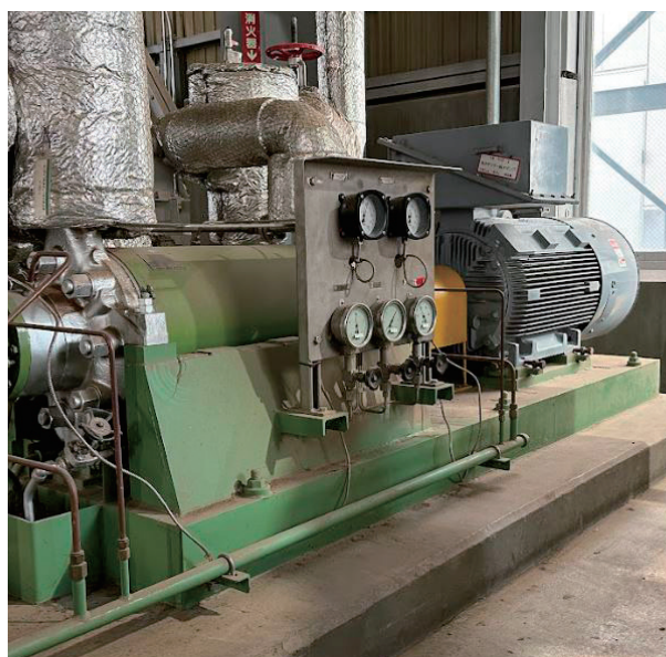
段抜きをしたボイラ給水ポンプ
