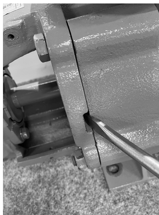
写真 5.2-1 ベアリングケース取り外し
