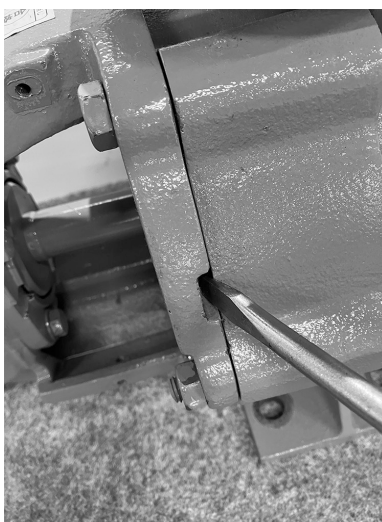
写真 5.2-1 ベアリングケース取り外し
