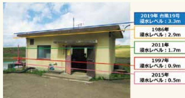
写真① 後谷地排水機場における過去の浸水レベル
