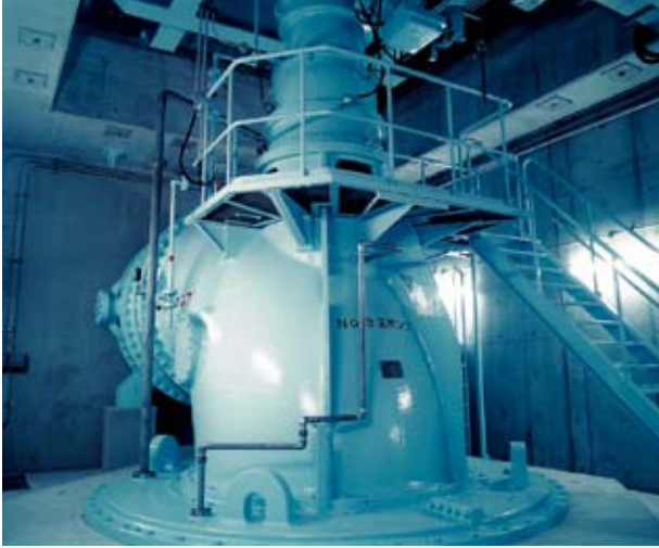
治水用 排水ポンプ (可動翼型) 口径：2,400mm 原動機出力：1,103kW
