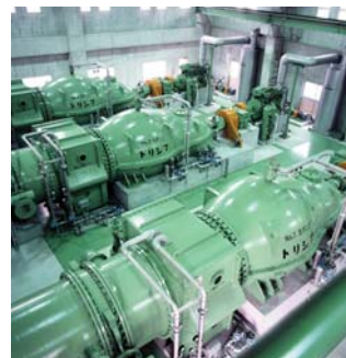
農業排水ポンプ場 (佐賀県)
