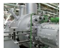
2015年(平成27年) 超臨界圧発電所向け ボイラ給水ポンプ (インド)
