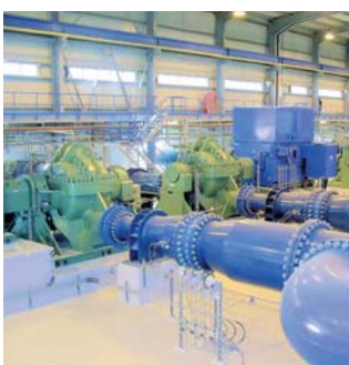
上水道用 長距離送水ポンプ場 (UAE)
