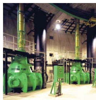
下水送水用 中継ポンプ場 (香港)
