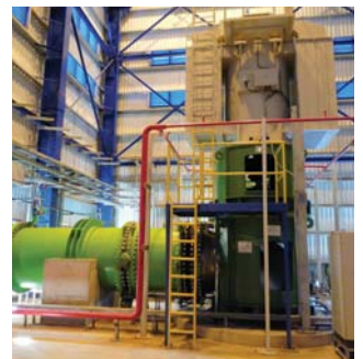
発電プラントでの冷却水ポンプ設備 (ベトナム)
