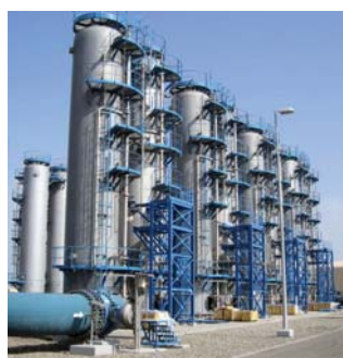
送水ポンプ場での圧カタンク (UAE)
