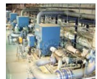
2007年(平成19年) RO法海水淡水化プラント向け 高圧海水供給ポンプ (オーストラリア)
