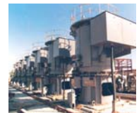
1976年(昭和51年) 化学コンビナート用ポンプ設備 (クウェート・シユアィハ地区)
