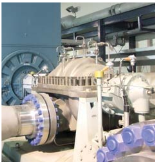
RO法 海水淡水化プラント用 高圧海水供給ポンプ
