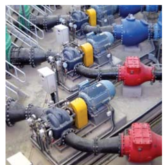
上水道用 配水ポンプ場 (カタール)
