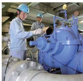
ポンプ設備の点検、診断
