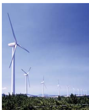
1500kW風車(福岡県)
