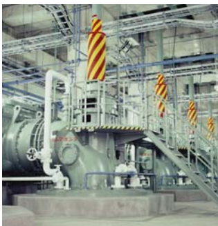
雨水排水ポンプ場 (東京都)
