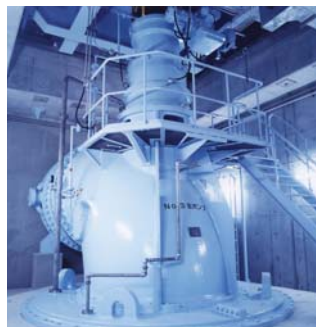
河川排水ポンプ場 (大分県)
