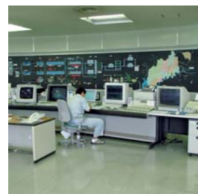
ポンプ設備の運転管理
