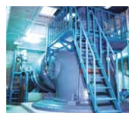
1981年(昭和56年) 九州最大の超大型排水ポンプ設備 (篠山排水機場)
