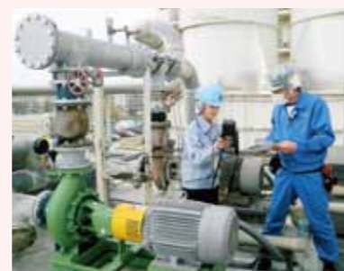
ポンプ設備の診断
