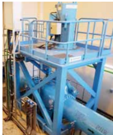
香港 Tuen Mun WTW 流量76.4m 3 /min、発電出力211.2kW
