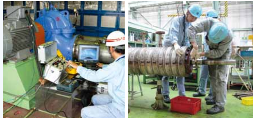
(左) ポンプ設備の点検 (右) ボイラ給水ポンプのオーバーホール
