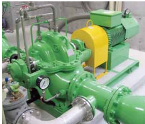
福岡市水道局 瑞梅寺浄水場 流量7.8m 3 /min、発電出力43kW
