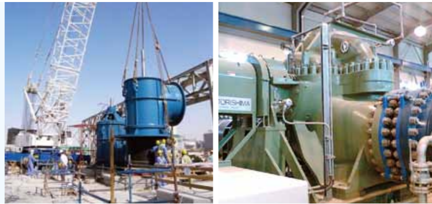
(左) 海水取水ポンプの据付 (右) 送水ポンプの試運転
