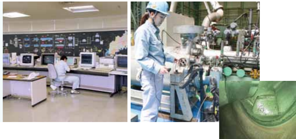
(左) 中央操作室での運転管理 (右) 内視鏡カメラによるポンプの内部診断
