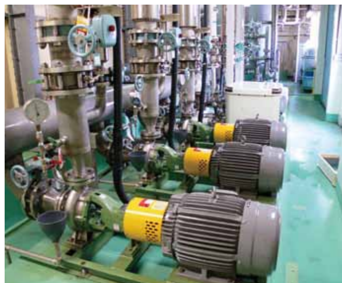
飲料水工場での原水ポンプ
