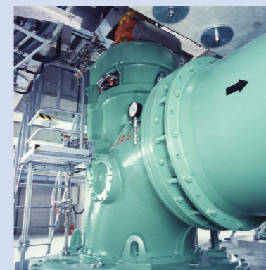
内部循環方式を採用した雨水ポンプ (φ1350mm 先行待機形)
