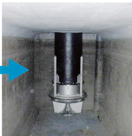
吸水槽内の吸込み管（渦対策機構付き）
