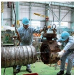
ポンプのオーバーホール
