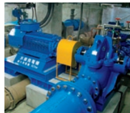
小水力発電システム(ポンプ逆転水車)
