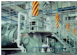
雨水排水ポンプ場
