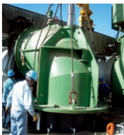
ポンプの据付
