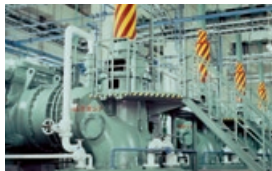
雨水排水ポンプ場
