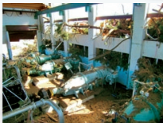
津波により搬入扉、窓が破損し、土砂が流入、機場内は屋根付近まで水没、電気設備が浸水
