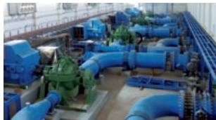
上水道用送水ポンプ場
