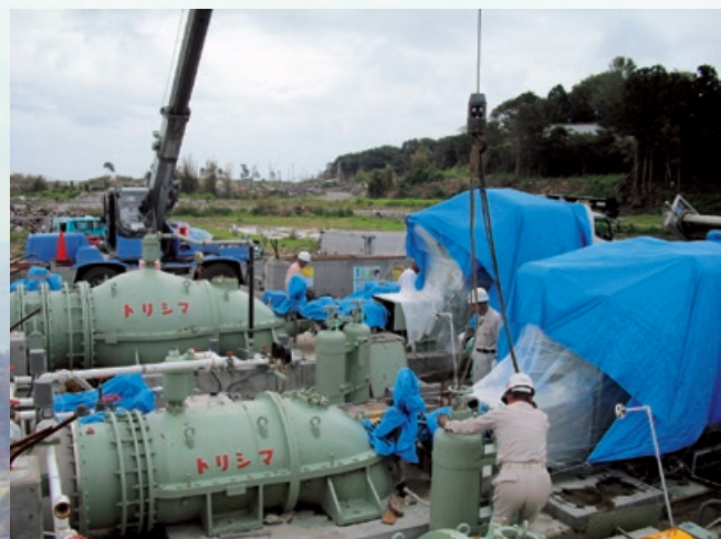
津波により全損、機能停止した排水機場の復旧作業
