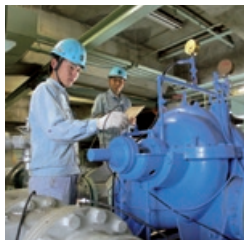
ポンプ設備の振動・騒音測定
