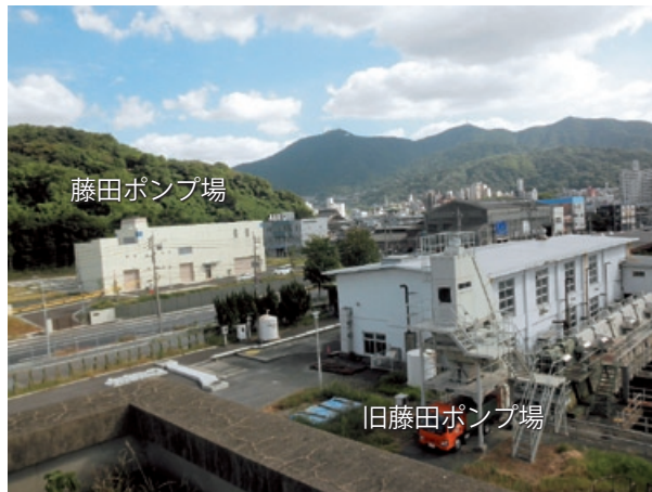
藤田ポンプ場 (左側) と旧藤田ポンプ場 (右側)
