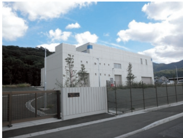
藤田ポンプ場の外観
