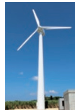
100kW 風力発電システム
