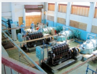
ポンプ、エンジン、減速機は現地で整備し、窓や搬入扉は合板で仮仕舞
