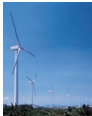
1500kW 風力発電システム
