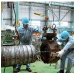
ポンプのオーバーホール
