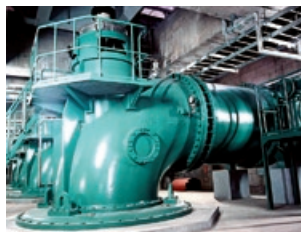
河川排水ポンプ場（群馬）
