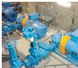
上水道用 取水ポンプ場（沖縄）
