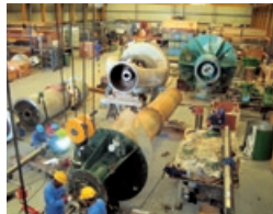
ポンプのオーバーホール
