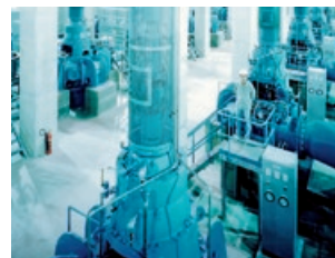
上水道用 送水ポンプ場（香港）
