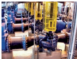
上水道用 配水ポンプ場（カタール）
