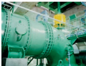
雨水排水ポンプ場（大阪）
