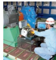
ポンプ設備の診断
