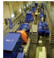
上水ポンプ場
