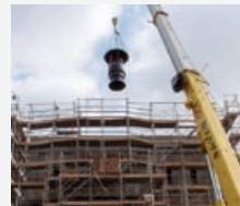
排水ポンプの搬入
