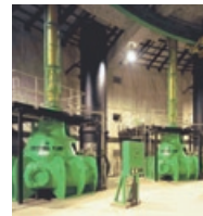
下水ポンプ場
