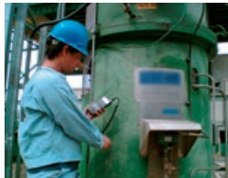
ポンプ設備の振動・騒音測定
