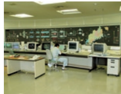
操作室での運転管理
