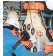
ポンプのオーバーホール
