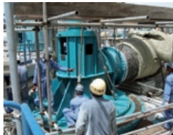
ポンプの据付
