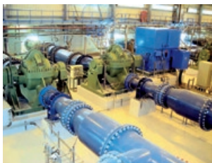
上水道用 送水ポンプ場（アブダビ）
