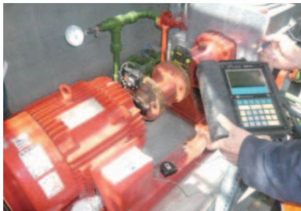
ポンプの保守点検(レーザー式シャフト芯出し)
