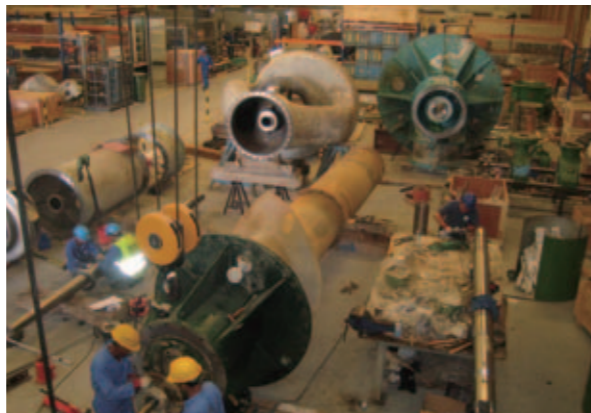
ポンプのオーバーホール
