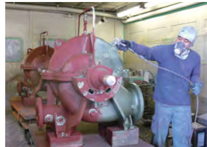
ポンプ塗装の様子
