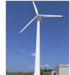
100kW風車(沖縄県久米島)
