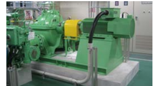
小水力発電施設(福岡市水道局乙金浄水場)
